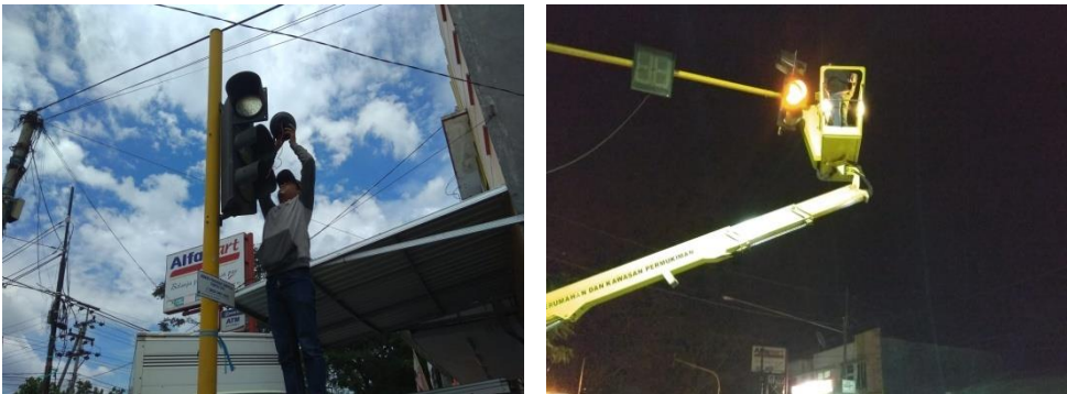
Gambar 3.2 Perbaikan Traffic Light
